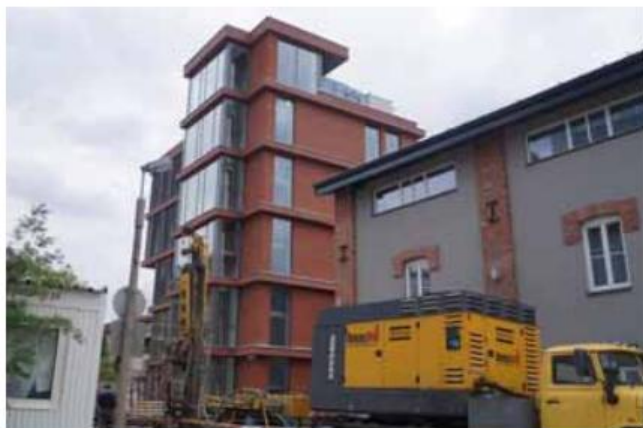
Budynek MLBE PK, na pierwszym planie wiertnica wykonująca odwiert GWC 125 m do pompy ciepła solanka/woda.
