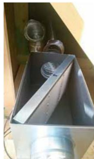
Rekuperator oraz filtry powietrza zastosowane w Tatra Green House.
