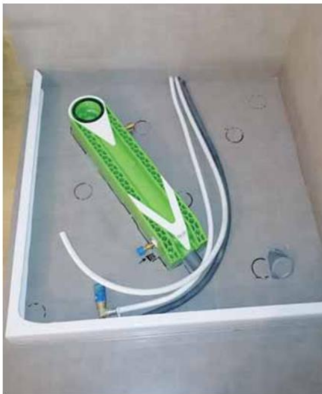
Rekuperator do odzysku energii cieplnej ze ścieków odpływających z prysznica.
