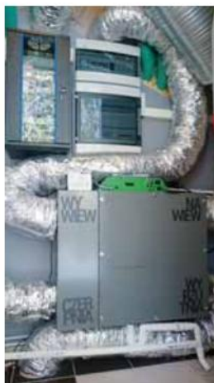
Rekuperator oraz filtry powietrza zastosowane w Tatra Green House.
