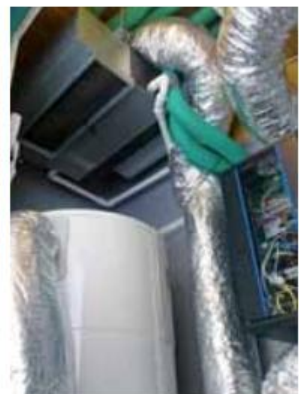
Jednostka zewnętrzna pompy ciepła i umieszczony wewnątrz budynku klimatyzator kanałowy.
