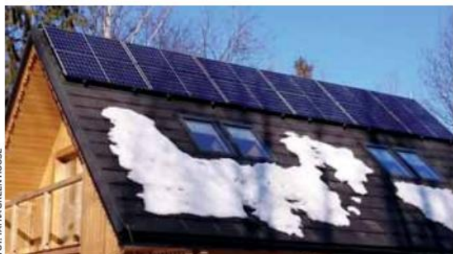
Odśnieżanie fotowoltaiki po obfitych opadach śniegu ręcznie i dzięki odwilży.
