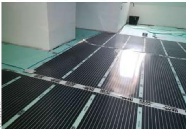
Instalacja elektrycznej folii grzewczej
