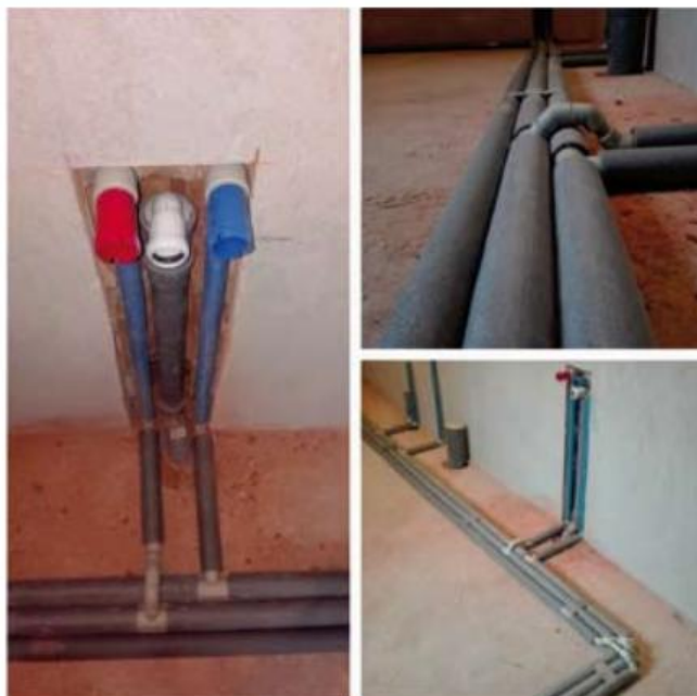
Instalacja wody w systemie polifuzyjnego grzewania rur PP. To jedyny system, do którego się przekonaliśmy. Jest tani i niezawodny. Od 1996 roku nie mieliśmy żadnej awarii ani wycieku na grzewcu.
