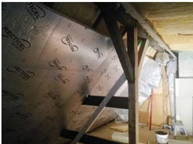
Montaż warstwy izolacji z płyty PIR
