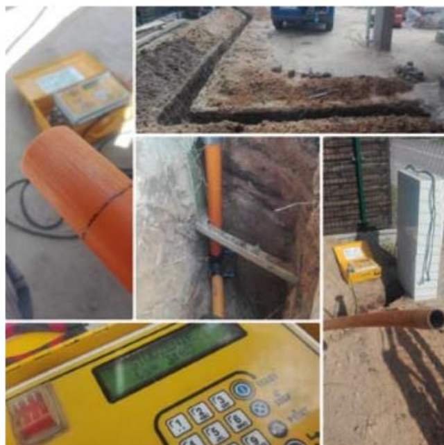
Czasem odcinki przyłącza gazowego są tak krótkie, że nie ma sensu angażować do pracy koparki. To 20-metrowe przyłącze zostało wykonane w 4 h, włączając w to główną próbę szczelności. Całość prac została przeprowadzona ręcznie.
